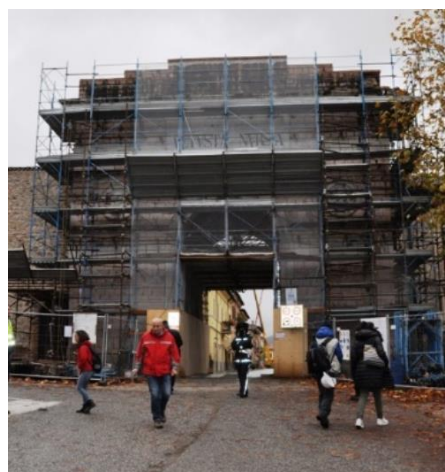
Interventi di messa in sicurezza successivi al sisma
