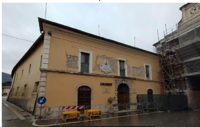
Prospetto su Corso Sertorio
