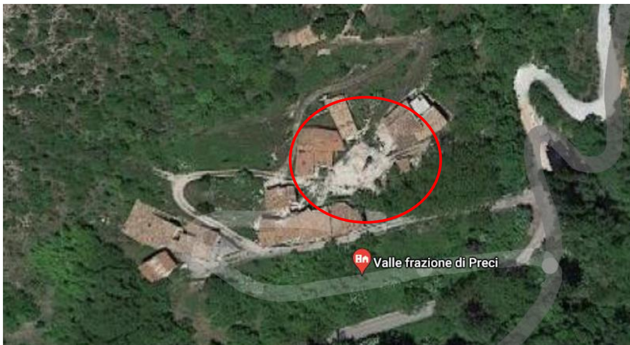
Localizzazione del dissesto in località Valle
