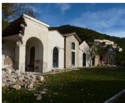
Messa in sicurezza delle edicole funerarie danneggiate e vista del crollo del muro di recinzione del cimitero
