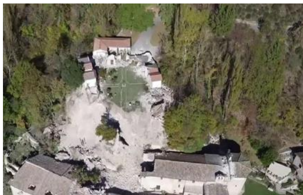
Vista del cimitero dopo del sisma
