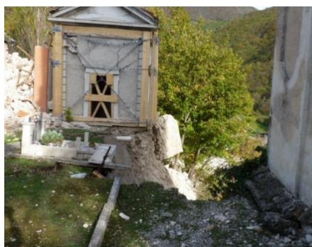
Messa in sicurezza delle edicole funerarie danneggiate e vista del crollo del muro di recinzione del cimitero
